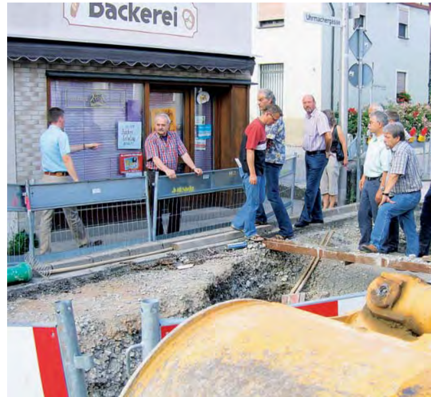
In der Uhrmachergasse überzeugten sich die Stadtratsmitglieder vor der Sitzung vom Baufortschritt. Die Kanalarbeiten sollen in der nächsten Woche, spätestens aber Anfang übernächster Woche fertig gestellt werden. Nach dem partiellen Austausch der Wasserleitungen geht es im August mit den Straßenbau-Arbeiten weiter. Foto: Berger
